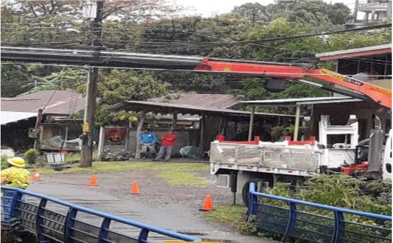
Figura 18. Colocación de paso para el mono congo en Río Piedras de Tierras Morenas, Tilarán
